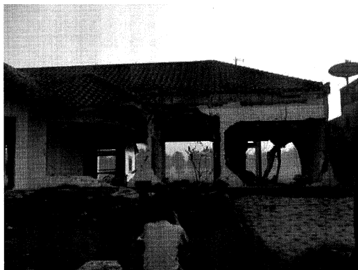
写真-1 津波で被災した海岸近くの家屋
