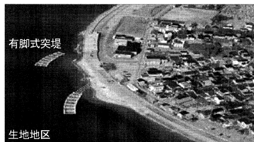
写真-2 下新川海岸生地地区における海岸保全施設
