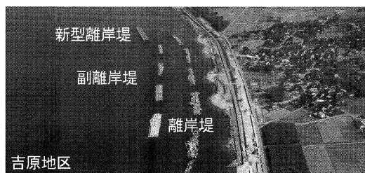
写真-1 下新川海岸吉原地区における海岸保全施設
