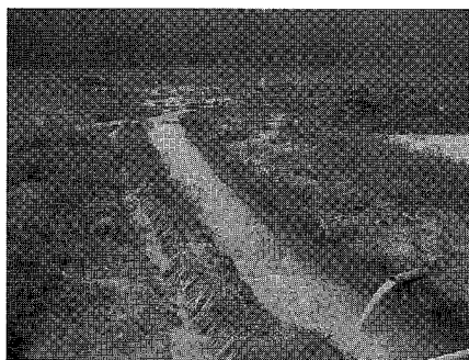
写真-3 除塩のための排水路掘削の例 (2005 年 7 月, タイ南部バンガー県 Bnag Niang 混合果樹園)
