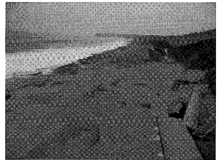
写真-1 伊師海岸の傾斜護岸崩壊と人工砂丘侵食(日立市)
