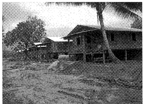
写真-5 津波後新たに建設された高床式の居住 (バンガー県 Bang Niang 地区，被災後6ヶ月経過，2005.7 撮影)
