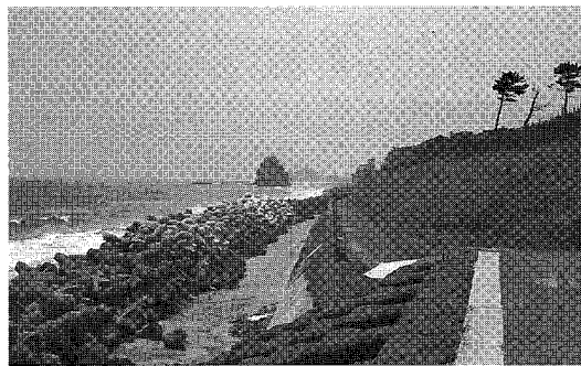
写真-5 神岡上海岸南部の護岸と消波ブロック
