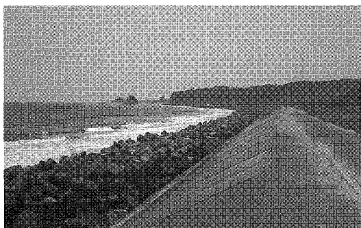
写真-3 保安林防護のための護岸と消波ブロック
