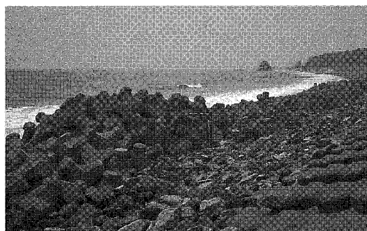
写真-4 神岡上海岸の侵食状況
