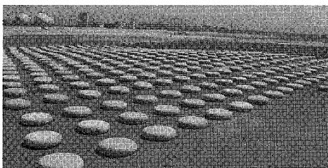
写真-2 転石ブロック
