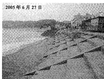
図-2 養浜の様子 (2005/6/27 撮影, No.36 付近)
