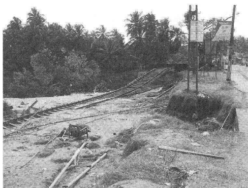
写真-2 Ambalangoda における津波による鉄道基礎の洗掘
