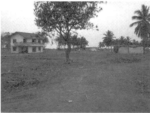
写真-1 Hambantota 住宅街の被害の様子 (既に整地されていた)
