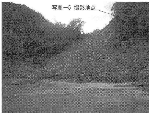
写真-6 津波により植生が削り取られ、山肌が露出した小山の鞍部 (Rhiting; 図-4地点 B 付近から西側を撮影)
