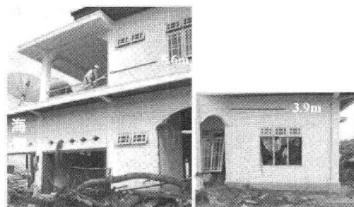
写真-5 中破家屋と津波痕跡 (Banda Aceh, 海岸から約 1.5 km 内陸)
