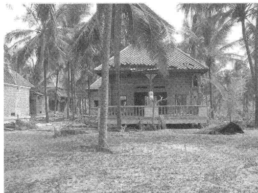
写真-8 植生域(上)と背後家屋(下)の被害状況 (Khao Lak, 地盤高 = 3.5m, 浸水深 = 4.6m, 植生域厚 = 28m, 植生密度 = 0.42%)
