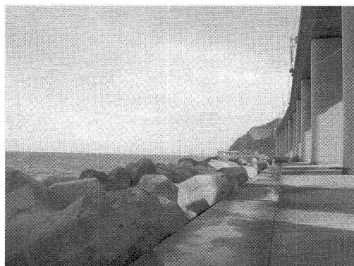
写真-1 親不知高架橋波浪対策護岸
