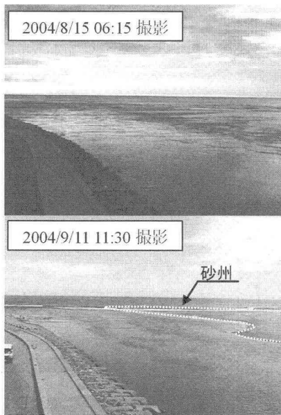
写真-2 CCTVカメラによる河口画像(八戸潮位 T.P.+0.0 m)
