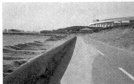
写真-3 フェンス前面・背後の堆砂を除去した後の状況
