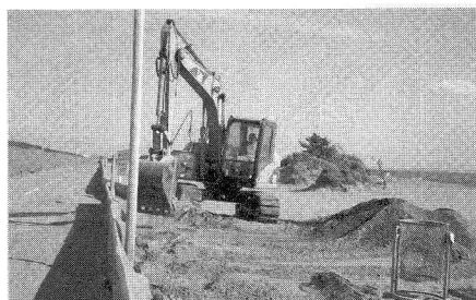
写真-2 フェンスと背後の遊歩道に堆積した砂の除去作業
