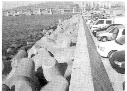
写真-3 Suyeong の護岸状況
