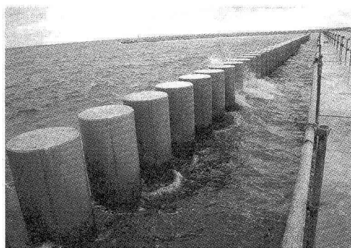
写真二 現地に設置された消波型高基混成堤（整備中）
