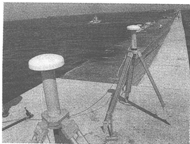
図-2(b) 防波堤上のリファレンス局のGPSシステム
