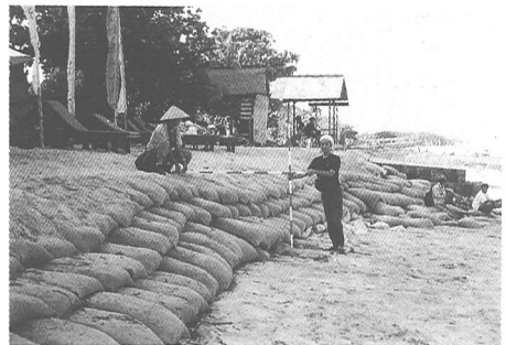
写真-3 侵食対策としての突堤と土嚢袋 (2001年10月16日)
