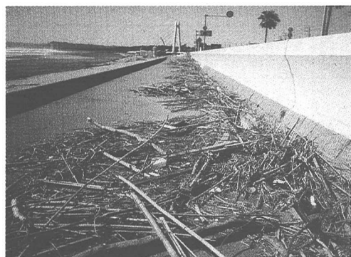
写真-6 1次対策箇所の越波後の状況
