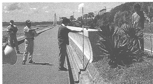
写真-5 1次対策後 (写真手前は未施工区間)
