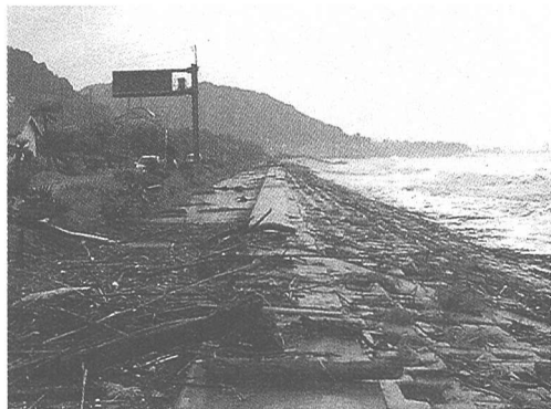
写真—1 2000年7月の台風3号による越波状況
