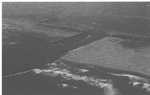
写真-1 今切口周辺海岸の現状 (2003 年 5 月撮影)
