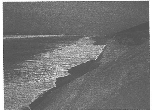
写真-2 新居海岸の侵食状況
