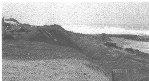
写真-1 舞浜浜砂投入状況写真
