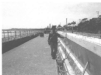
写真-2 護岸嵩上げ工事の状況 (2002年4月)
