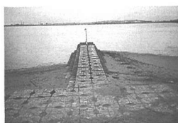
写真-1 水制②の中心線から2001年3月9日に撮影した砂浜状況
