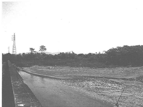
写真一2 舞手川河口砂州の状況
