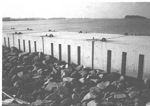
写真一1 馬堀海岸の現状(平成14年4月)
