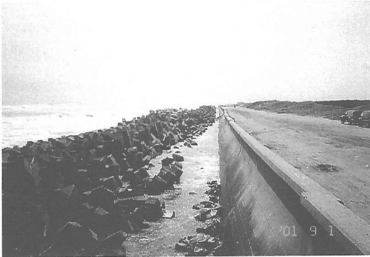
写真-4 直立護岸とうず高く積まれた消波ブロック (2001年9月1日撮影)
