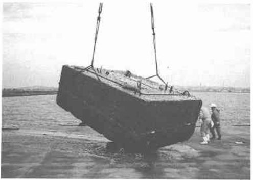
写真-1 供試体収容函引上げ状況
