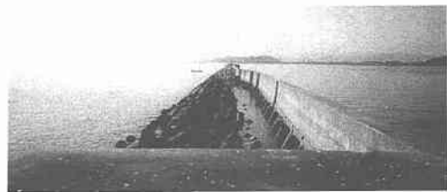
写真-2 L型塊および消波工の移動状況
