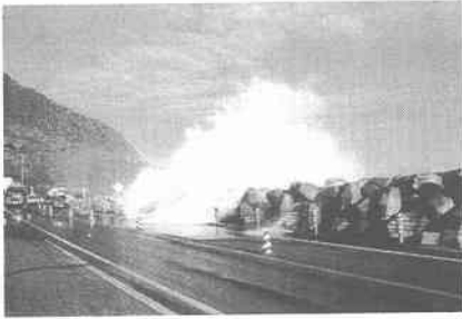
写真-1 現地における越波状況
