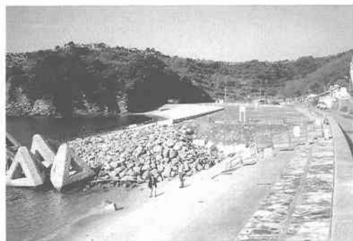
写真-7 旧護岸線の延長上から工事区域を撮影
