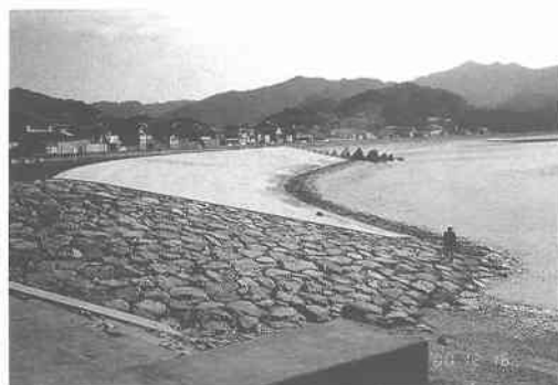
写真-6 緩傾斜護岸の全景
