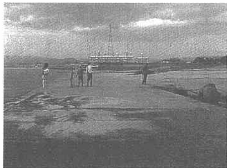
図-7 仕切堤に打ち上げられた砂
