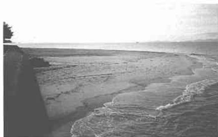
写真-9 砂州の西端部と護岸前面の捨石の関係 (1998年4月27日撮影)
