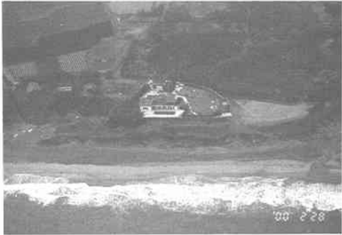
写真-1 構造物前面の砂丘侵食
