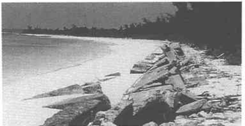
写真-4 侵食災害
