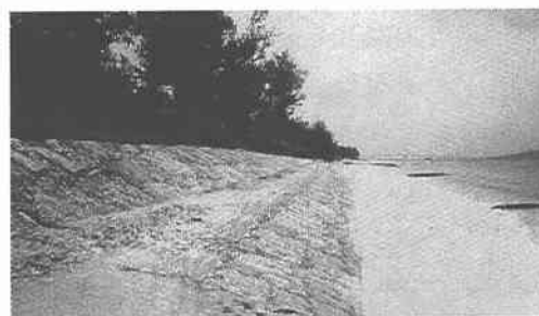
(c) 砂浜前面に自然的な突堤を配置
