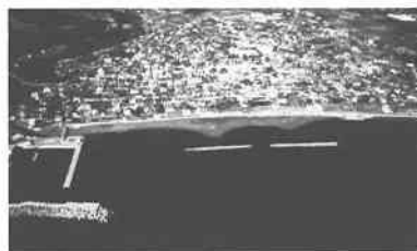
写真-5 離岸堤背後の堆積と周辺侵食（川尻海岸）
