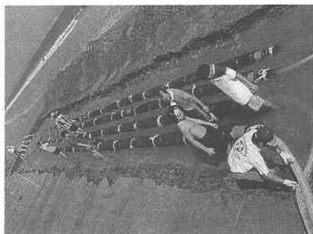
写真—1 用いた集水管
