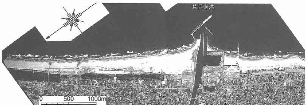
写真-1 片貝漁港周辺の空中写真（1999年撮影）
