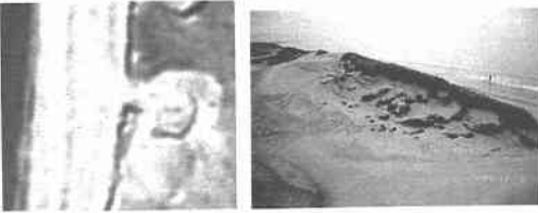
写真-5 海側境界が切れた風食孔の例
