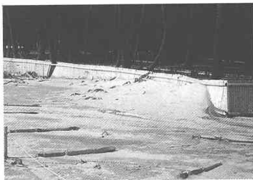
写真一1 防風垣前面の砂の堆積 (1999 年 9 月 24 日)
