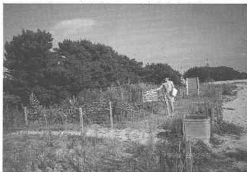
写真-2 台風来襲前の後浜天端（1999年8月）
