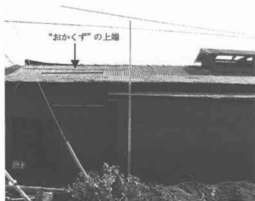
写真-3 浸水痕跡高の調査状況
