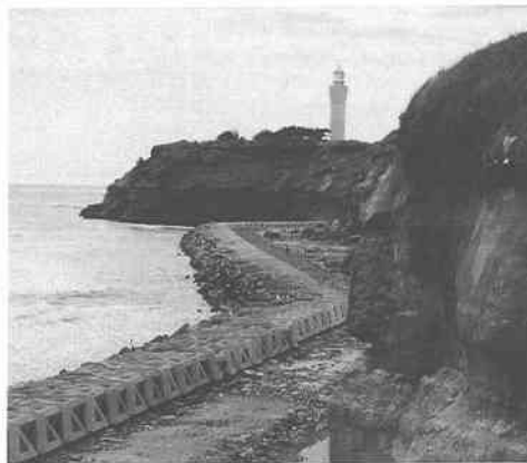
写真-1 大甕海岸の現状
