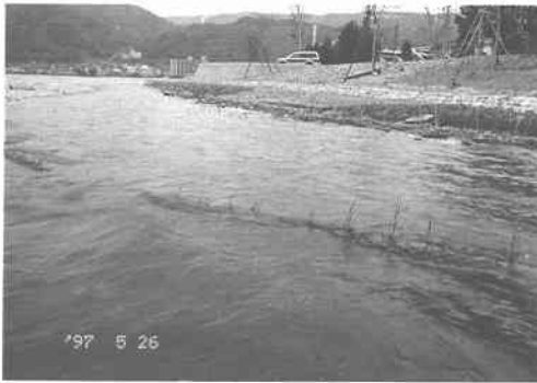
写真-1 設置から3ヶ月後の植生マットの状況
