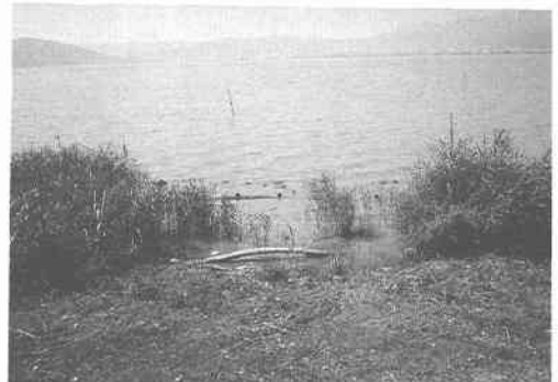
写真-4 無植生部分背後の湖岸浸食 (その2)
