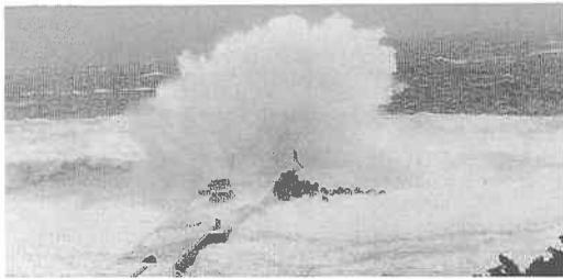
写真-1 急勾配海底上のケーソンに働く衝撃砕波力
