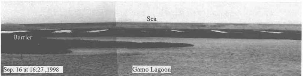
写真-4 越波の様子 (3)
