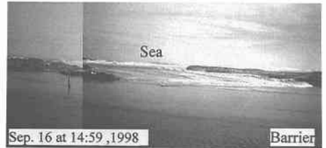
写真-3 越波の様子 (2)
