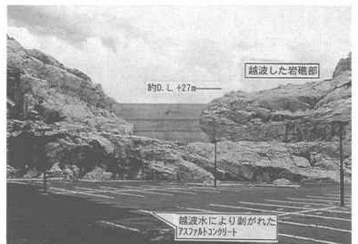
写真-1 越波した岩礁部
