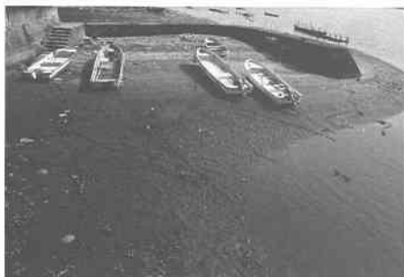
写真-1 首捻防波堤周辺の産卵地を西側から望む
