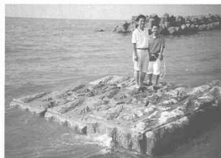
写真-7 人工岩礁の試験施工
