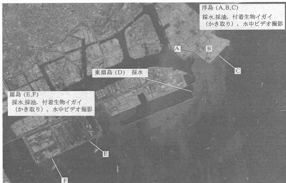
写真-1 調査地および調査項目（浮島，扇島：白濁した部分が油の密度の濃い範囲），7月3日（14：15-15：33）撮影）
